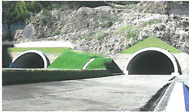
第二東名清水第四トンネル [静岡県]
